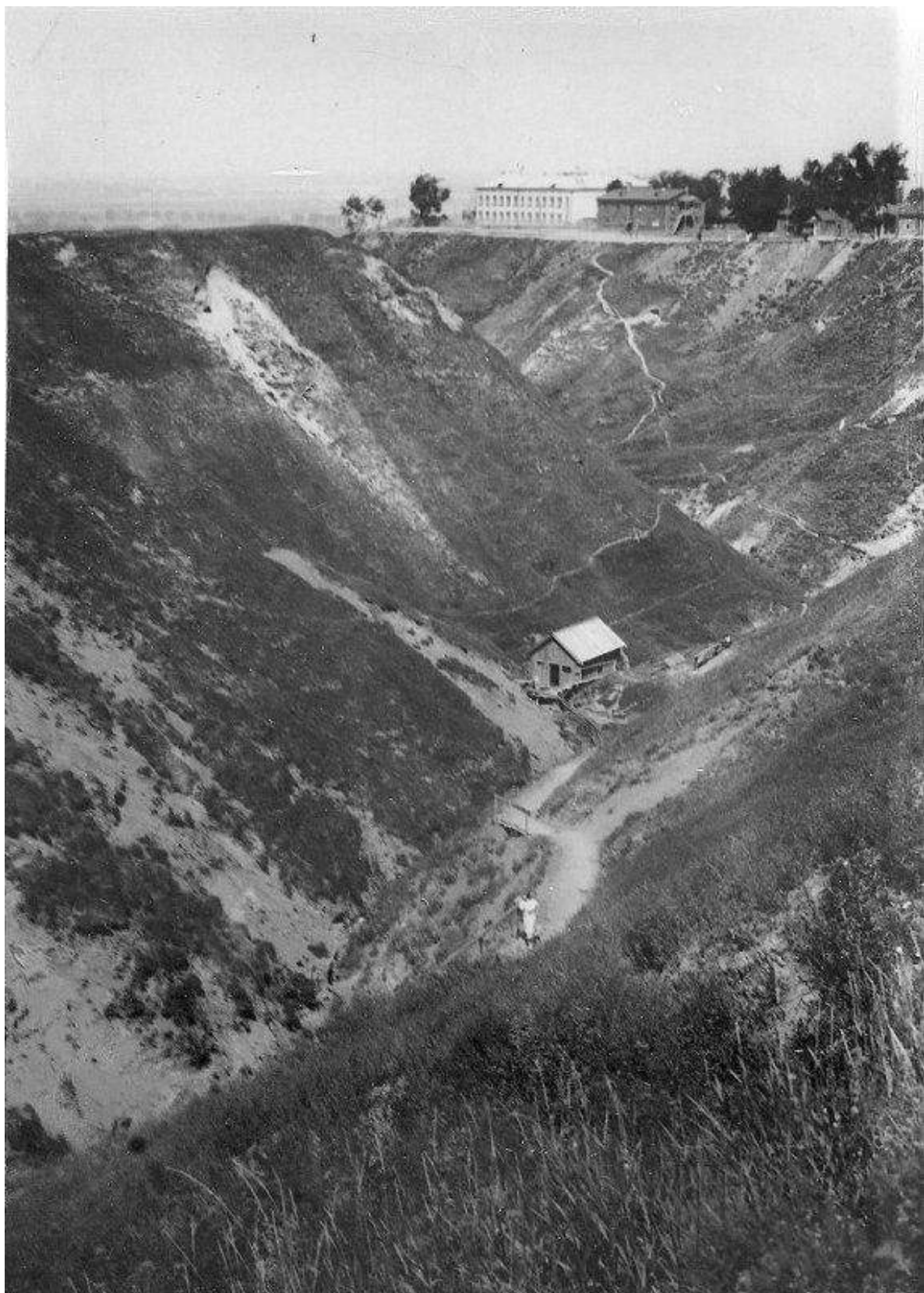
Илл. 17. Нижегородская область, г. Нижний Новгород, строительство автомобильной дороги, соединяющей автомобильную дорогу 22-401 ОП МГ 2218 «Ул. Шевченко от ул. М. Ямская до ул. Дальняя» и автомобильную дорогу 22-401 ОП МГ 2633 «Проезд от ул. М. Ямская до дома 17 по ул. Большие Овраги» - 2026 г. Исторические фото участка проектирования. Жандармские (Большие) овраги. 1937 г. Автор фото не указан (источник - ГОСКАТАЛОГ.РФ).
